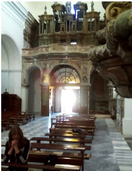
Zniszczone organy w kościele św. Antoniego w Zbarażu
