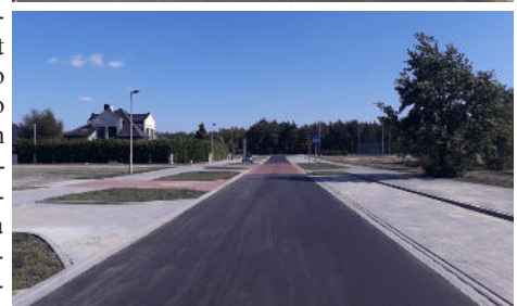
Ulice św. Antoniego i Owsiana po remoncie
