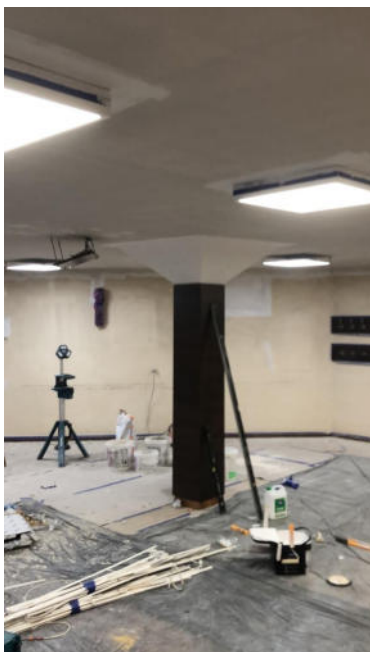
Kolejne prace remontowe – w sali pod kaplicą
