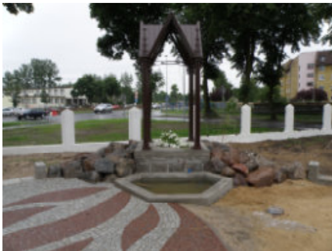
Kapliczka w budowie
